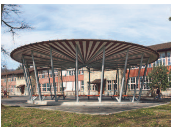
Pavillon Schulhaus Entlisberg Tragende Struktur aus verzinkten starkwandigen Stahlrohren
